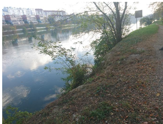
Slika 2: Nabrežje pri Koroškem mostu
