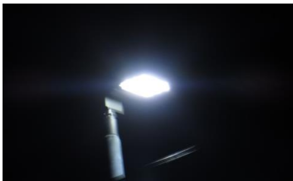
Slika 6: Popolnoma zasenčene svetilke na Valvazorjevi ulici na Studencih (lastna fotografija, 5. 1. 2018)
